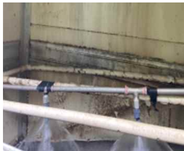
분진제거 장치 설치
