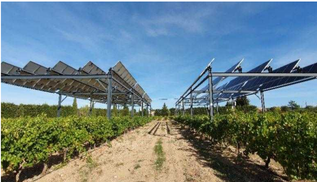
<그림 9> 프랑스 아비뇽 포도농장 영농형 태양광 발전소 전경
