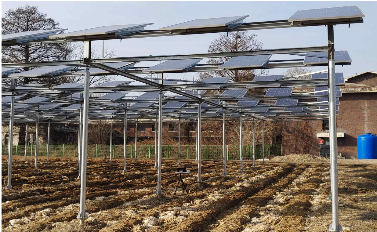
영농형 태양광 시설 하부 <그림 143> 미기상과 작물 생육을 감시하기 위한 시스템
