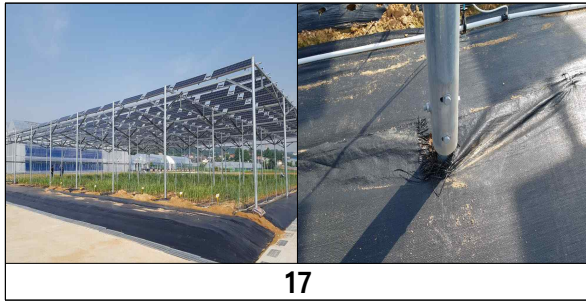
<그림 48> 영농형태양광 하부 구조 및 작물재배 방법 (태양광 순서: 표 10과 동일)
