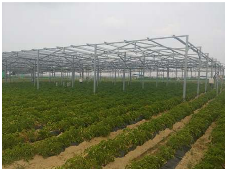
<그림 11> 오창 감자밭 영농형 태양광 시설
