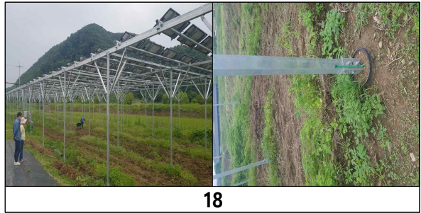
<그림 48> 영농형태양광 하부 구조 및 작물재배 방법 (태양광 순서: 표 10과 동일)
