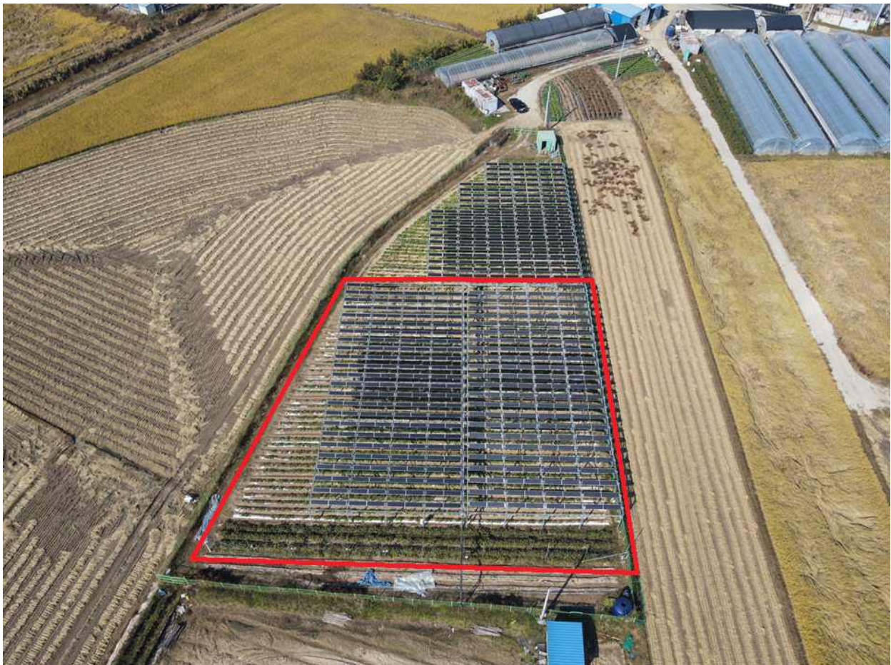
<그림 9> 오창 감자밭 영농형 태양광 시설
