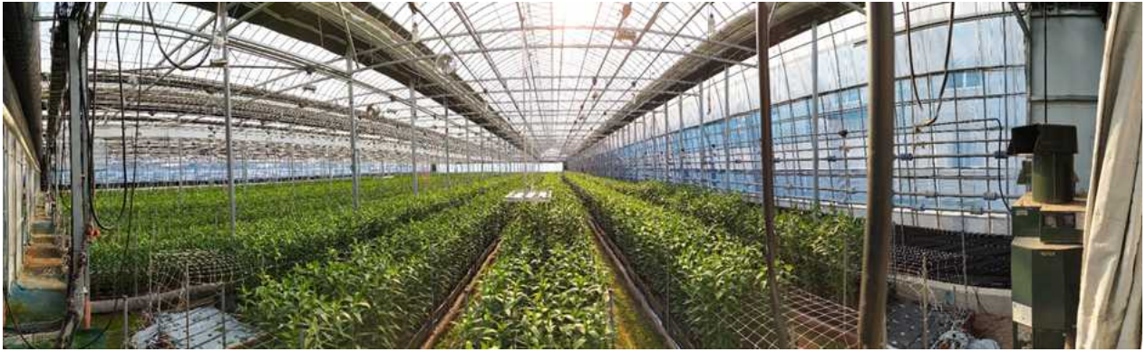
그림 2-3-5-8. 실증 대상 온실 내부 전경
