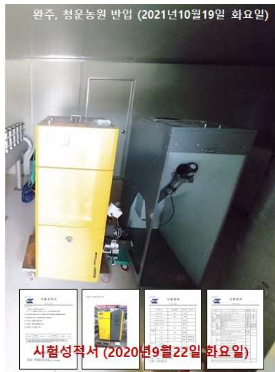
그림 2-4-1-3. 53 kW th 급(약 20 RT 상응) KS인증 바이오 설비(목재펠릿보일러) 한국에너지기술연구원 시험성적서 발급 후 반출, 이송 및 신규 구축한 실증온실(전북 완주 청운flower) 기계실 내부 설치
