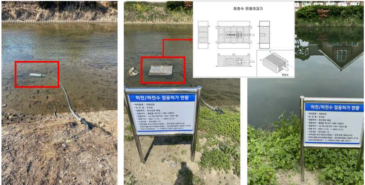
그림 2-5-4-5. 모래여과장치 및 하천수 취수구 설치
