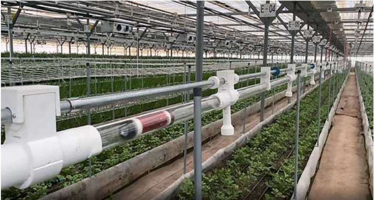
그림 2-5-5-1. 고도화 센서 시스템 실증 온실 현장 적용 테스트 전경
