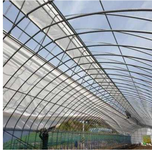
하우스 비닐 설치
