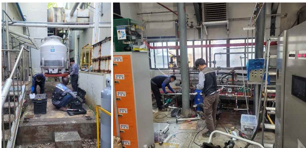
[그림 375] 보일러 및 방열 배관 설치
