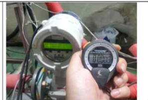
유량 측정 사진
