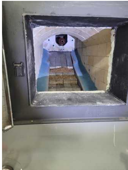
[그림 376] 보일러 내부 연소실 화격자
