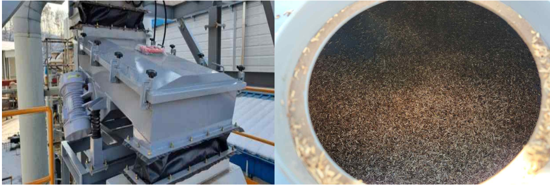
그림 110. 진동피더 설치사진 및 내부 이송 사진.
