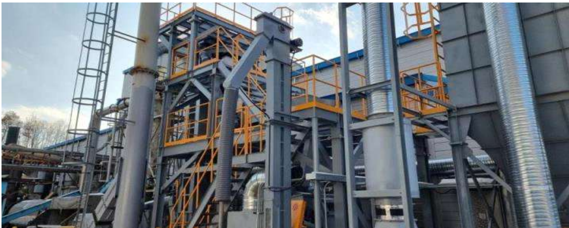
그림 120. 최종 선별기 설치 실증사진.
