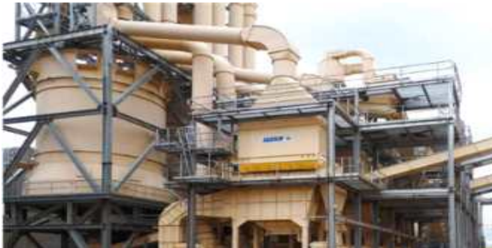
그림 8. Wind sifter 실제 적용사진
