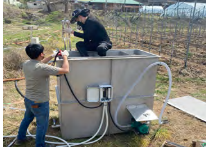
수처리 시설 및 UV램프 설치
