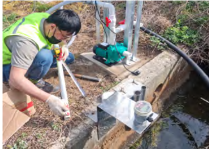
초음파 수위계 및 부유물질(SS)센서 설치
