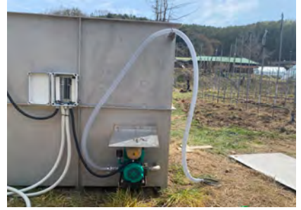
점적관개 호스 및 펌프 설치
