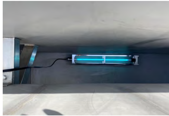
내부 UV램프 설치
