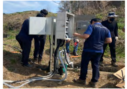
모니터링 시스템 제어함 설치
