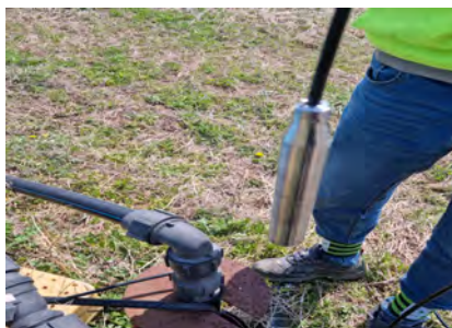
지하수 관정 수위계 설치
