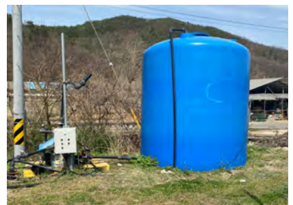
지하수 자동 펌프 밸브 및 펌프 제어반 설치
