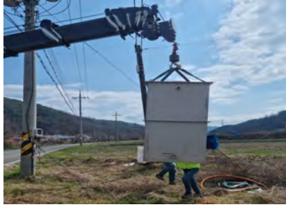
다기능 저류조 설치
