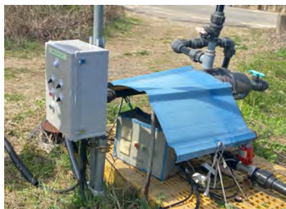
지하수 자동 펌프 밸브 및 펌프 제어반 설치
