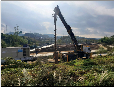
(a) 설치 위치 천공
