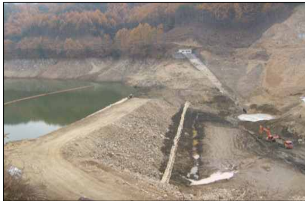
[그림 1-2] 농업용저수지 가물막이 공사 전경
