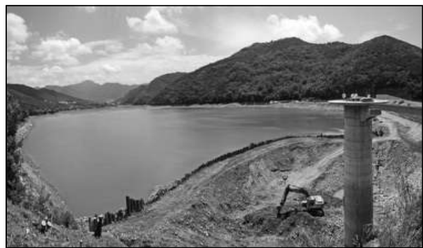
[그림 2-3] 토제와 강널말뚝을 이용한 가물막이
