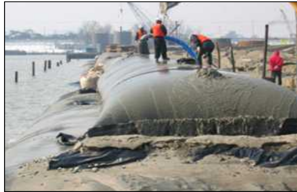
[그림 2-7] 가물막이 사진(일산대교)
