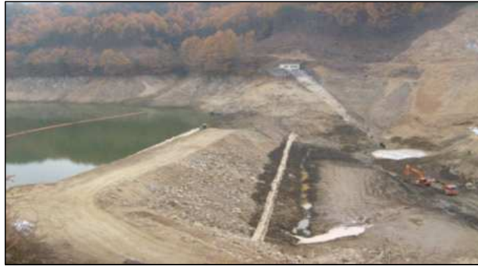
[그림 2-1] 농업용저수지 가물막이 공사 전경
