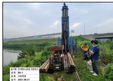
(a) 시추 전경(BH-1)
