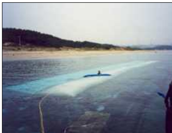
[그림 2-13] 울진 원전 수중잠재 설치 사진
