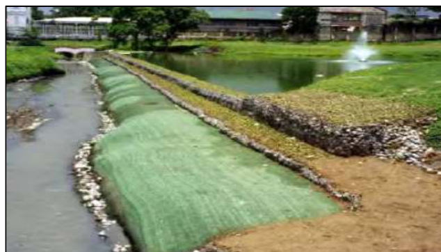
[그림 2-18] 지오텍스타일 튜브를 이용한 소형 댐 공사
