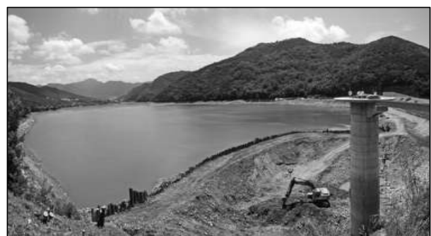
[그림 1-4] 토체와 강널말뚝을 이용한 가물막이 공법
