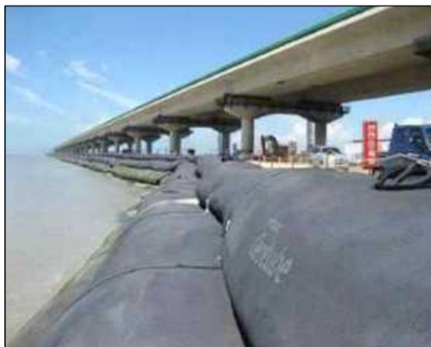
[그림 2-8] 인천대교 가물막이 사진
