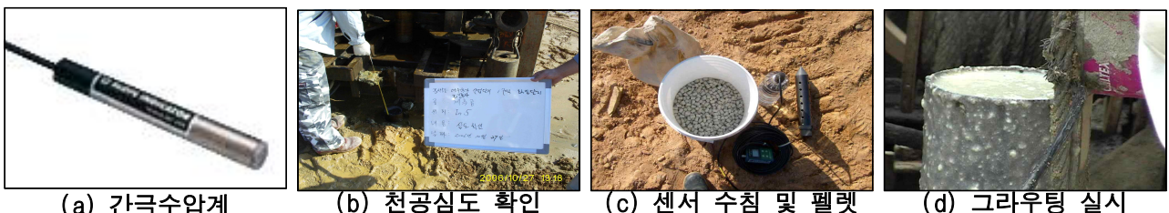
[그림 3-46] 감압정 간극수압계 설치 사진
