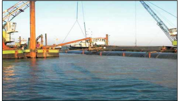
[그림 219] 지오텍스타일 튜브를 이용한 방파제 공사 (고정용 틀 사용) [그림 220] 지오텍스타일 튜브를 이용한 준설토 투기 제방 공사
