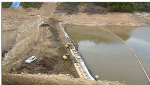
[그림 1-3] 토체와 대형마대를 이용한 가물막이 공법
