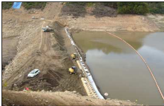
[그림 2-2] 토제와 대형마대를 이용한 가물막이
