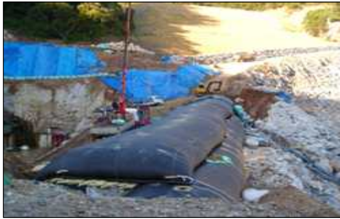
[그림 2-9] 수어댐 여수로 가물막이 사진
