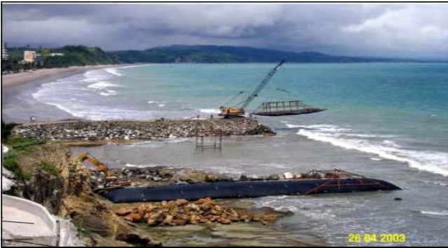
[그림 219] 지오텍스타일 튜브를 이용한 방파제 공사 (고정용 틀 사용) [그림 220] 지오텍스타일 튜브를 이용한 준설토 투기 제방 공사
