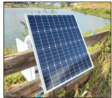
(c) 태양열발전설비 설치
