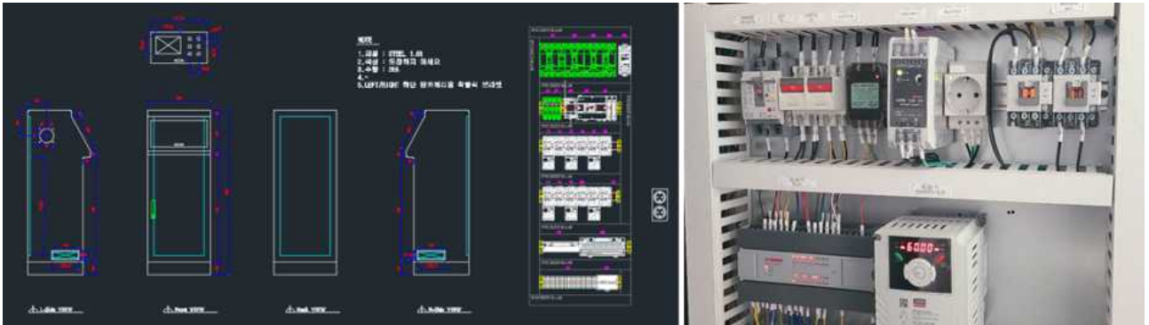
[그림 40] PLC 제어를 위한 제어컨트롤러
