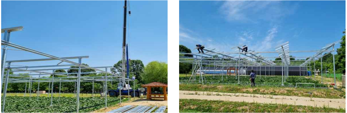
(b) 상부 보 및 가대 시공
