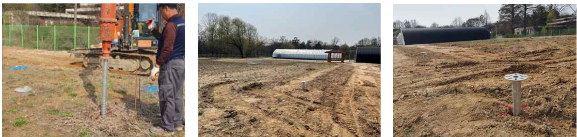
그림 103 스크류 기초 시공 및 평탄화 작업
