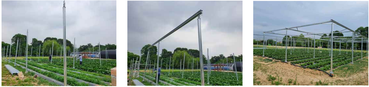
(a) 기둥 및 보 부재 시공
