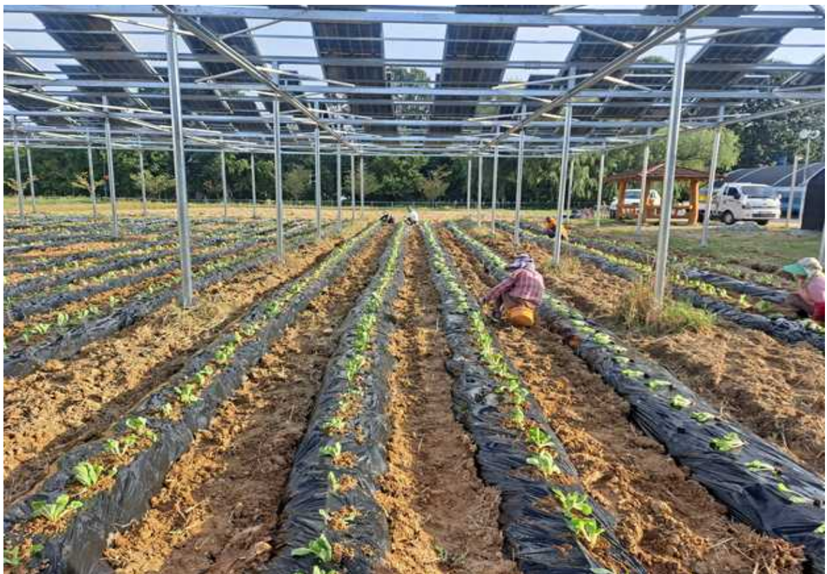
그림 105 영농형 태양광 시스템 - 수원 가을배추 재식
