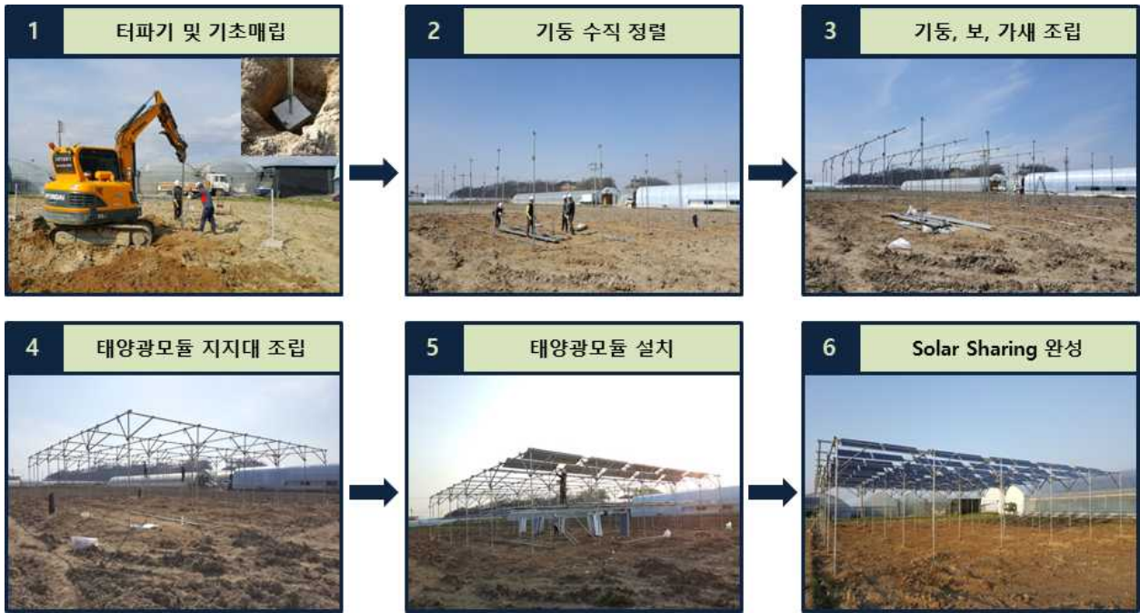
그림 100 영농형 태양광 시스템 구조물 시공 기본 프로세스
