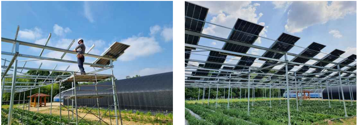
(c) 태양광 모듈 설치
