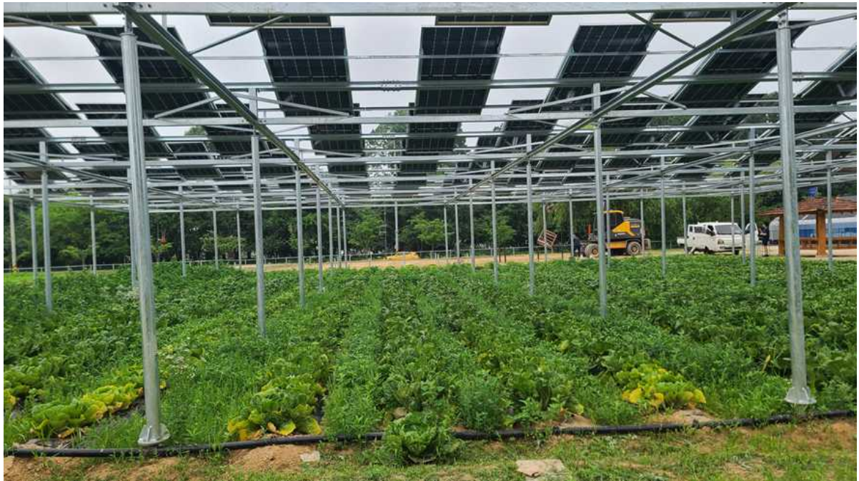
그림 104 영농형 태양광 시스템 - 수원 봄배추 재식
