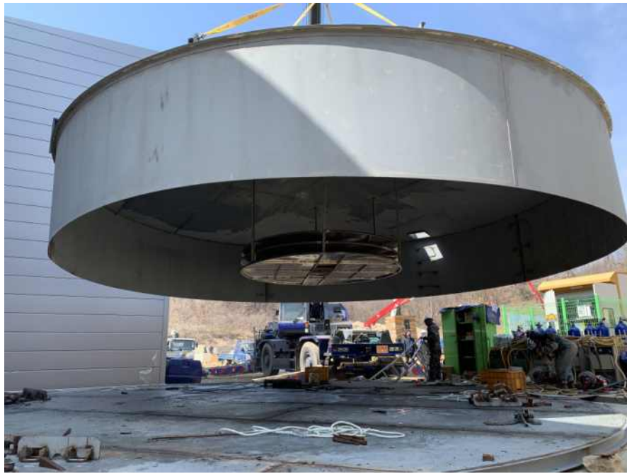
[그림 2-16. 외형 셸 및 디퓨저 설치 사진]
