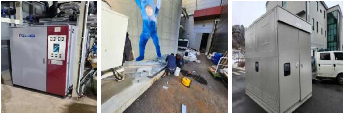
[그림 3-16. 전기보일러 증설공사 사진]
