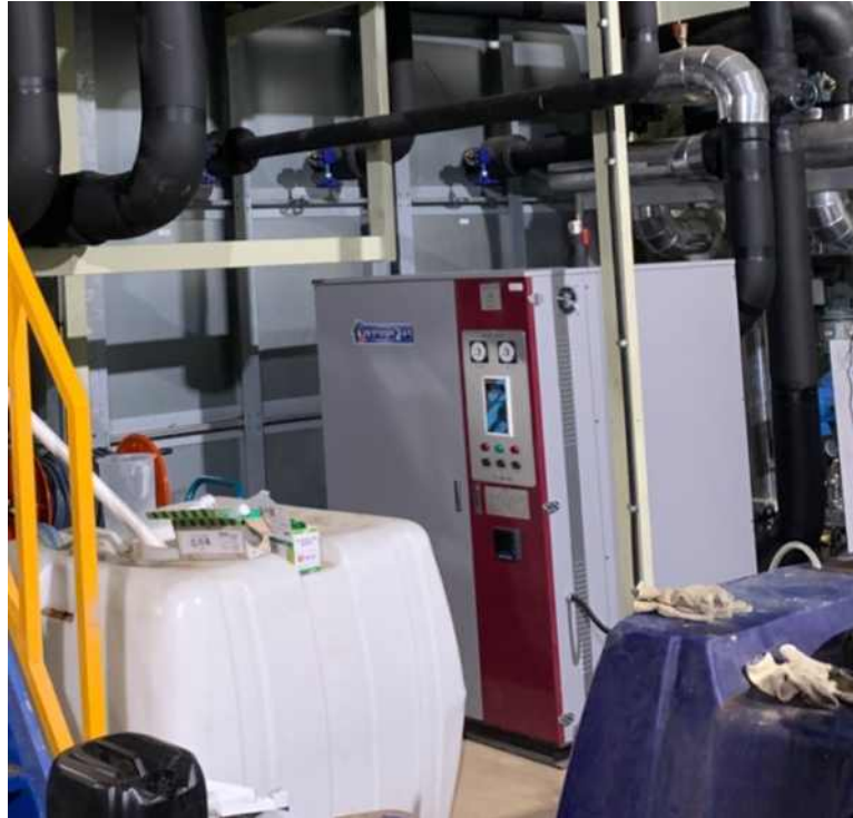
[그림 3-33. 비상용 전기 보일러 용량 증설]
