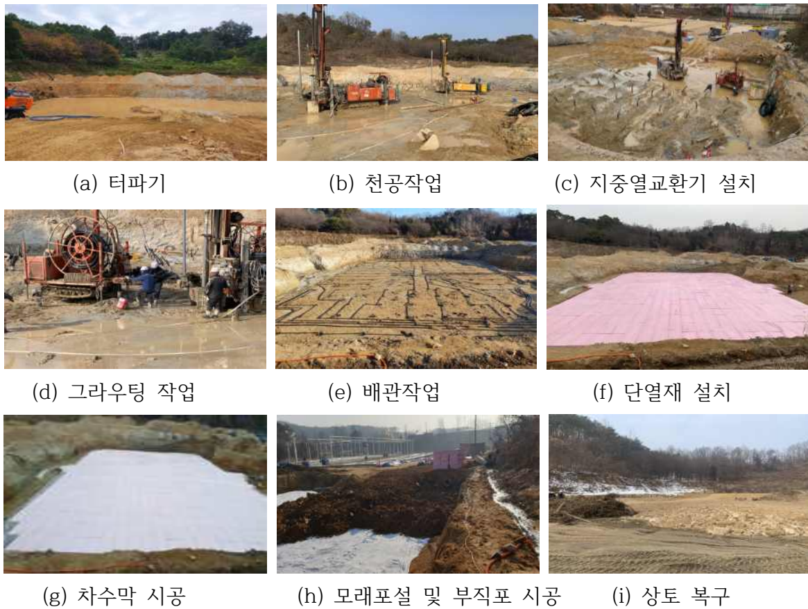
[그림 2-22. 실증단지 지중축열조 설치공사]
