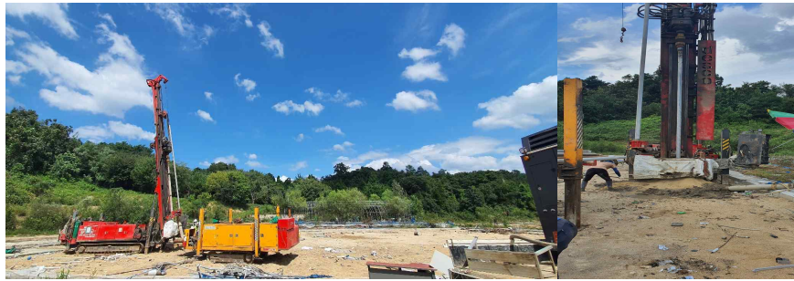
[그림 1-10. 현장 지질조사 시추 현장 사진]
