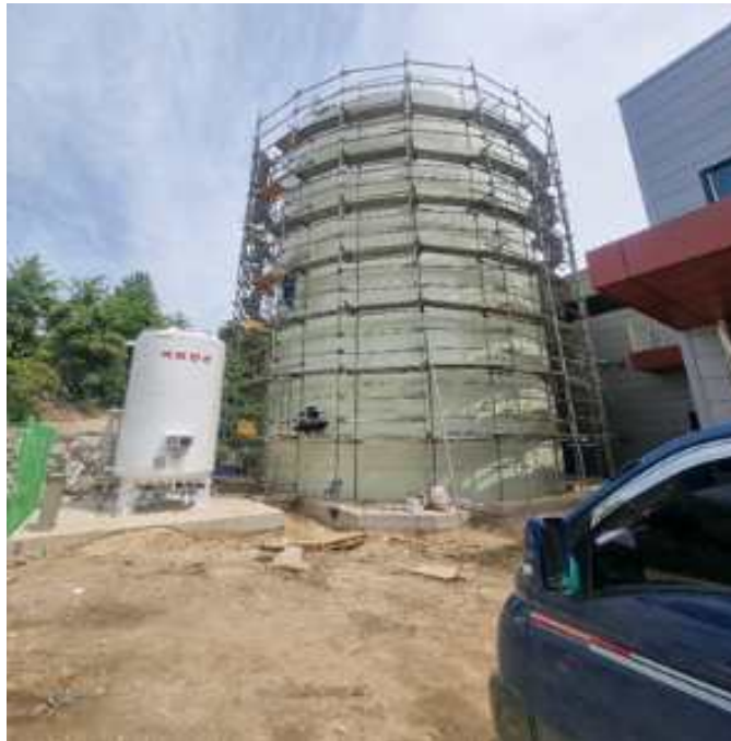
[그림 2-19. 보온 및 외부판넬 설치]
