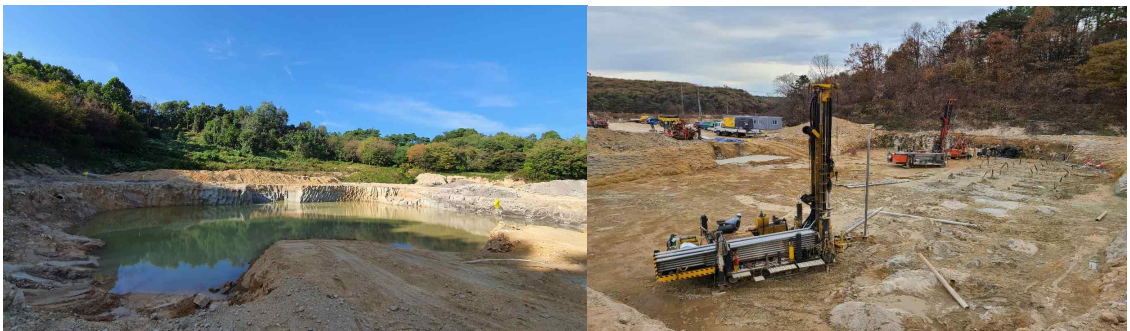
[그림 1-14. 터파기 현장 사진- 우천으로 물이 고인 모습, 천공 진행 중인 사진]
