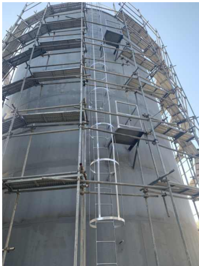
[그림 2-17. 외부 용접 및 비계설치]
