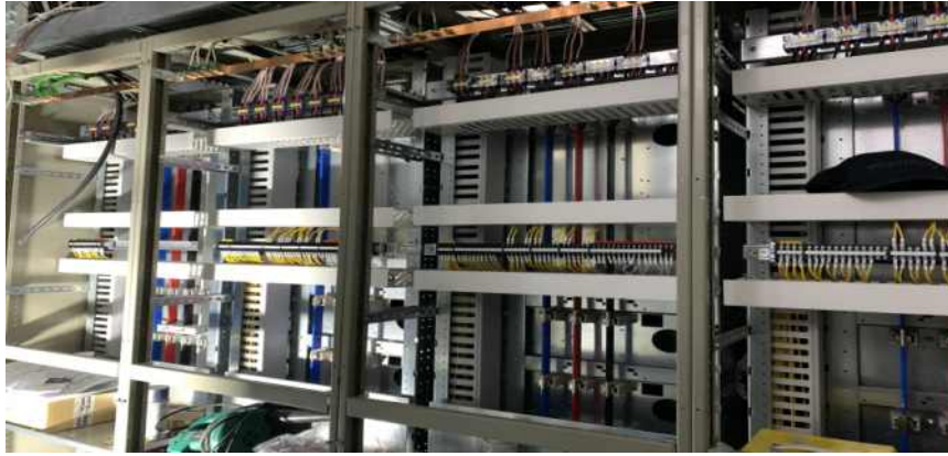
[그림 2-28. 기계실 제어기 공사]
