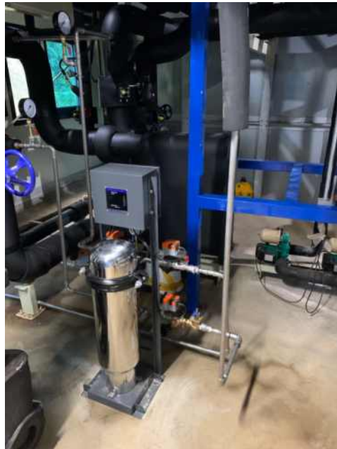
[그림 3-30. 울트라 샌드 필터(USF) 설치 완료 사진]
