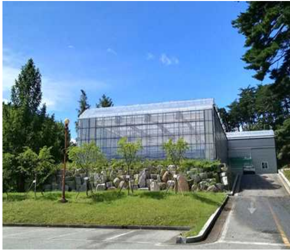
[그림 2.3] 강릉 자체 테스트베드 온실 현장(전체면적: 700평, 재배작목: 토마토·딸기, 사용배지: 압면, UV 살균모듈구조: Swirl 타입, 처리용량: 1톤 및 2톤/시간)
