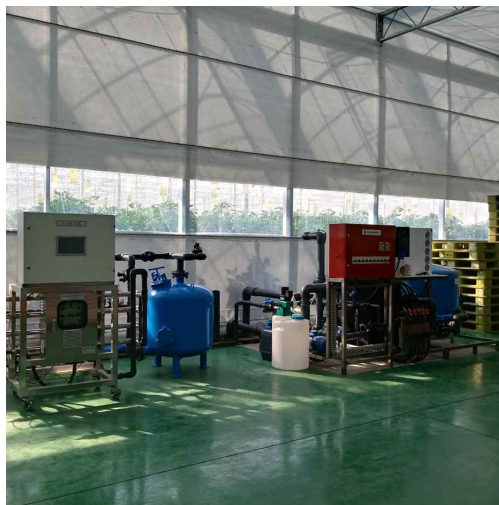
[그림 2.4] 마산 진동면 K 농가 실증현장(전체면적: 6000평, 재배작목: 파프리카, 사용배지: 코코 피트, 정식일: 2019년 8월 10일, UV살균모듈 구조: Swirl 타입, 처리용량: 2톤/시간)
