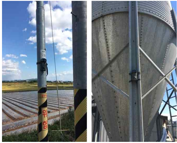
<그림 16. 관찰 카메라의 설치>
