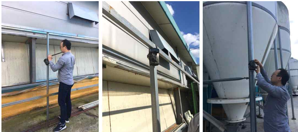
<그림 20. 관찰 카메라의 설치 >
