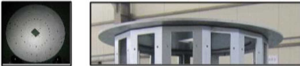
<그림 3-05-29> TOP CON BASE PLATE(좌), 부착사진(우)
