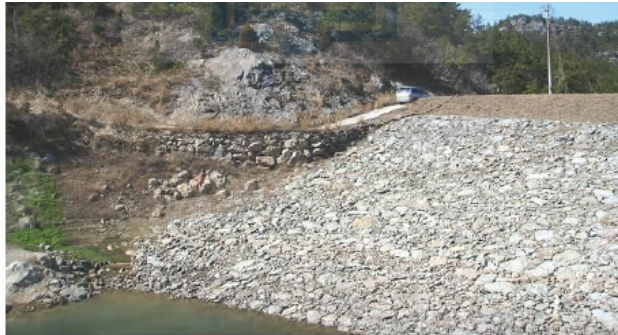
<그림 6-1> 댐의 상류사면 좌안부 전경
