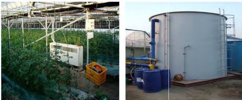
그림 11. 수평형 지열히트펌프 시스템 (경북 영천시 소재)
