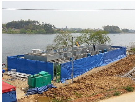
④ 조립 및 배관시공
