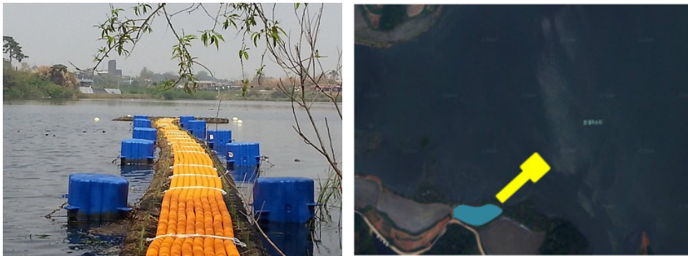
<그림 2.26> 방류배관 및 인공식물섬 설치모습(좌)과 설치위치(우)
