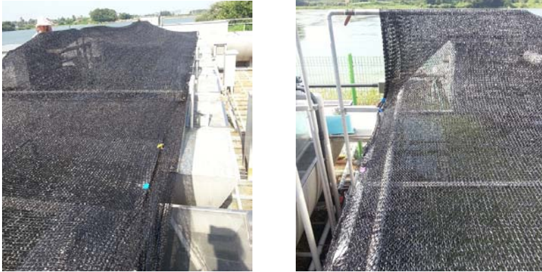
〈그림 2.28〉 차양막 설치 모습
