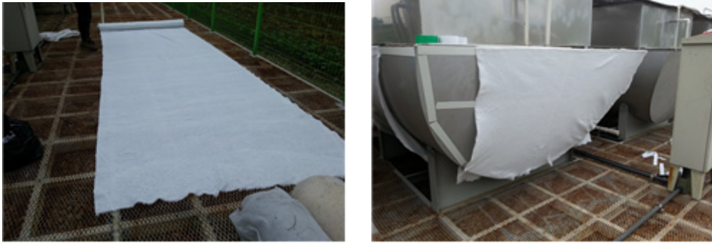
〈그림 2.29〉 단열재 설치 모습
