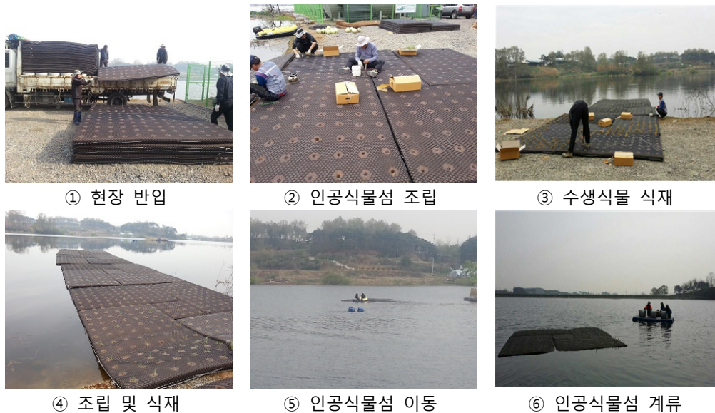
〈그림 2.33〉 인공식물섬 설치 과정
