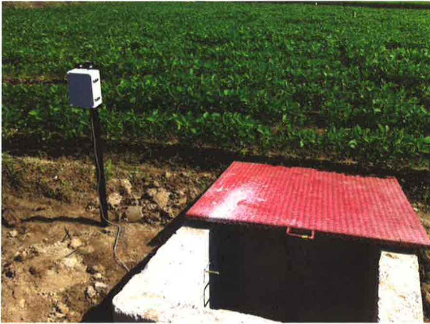
[그림 5.78] 배수량 측정용 강우량계 Data logger 함체 설치
