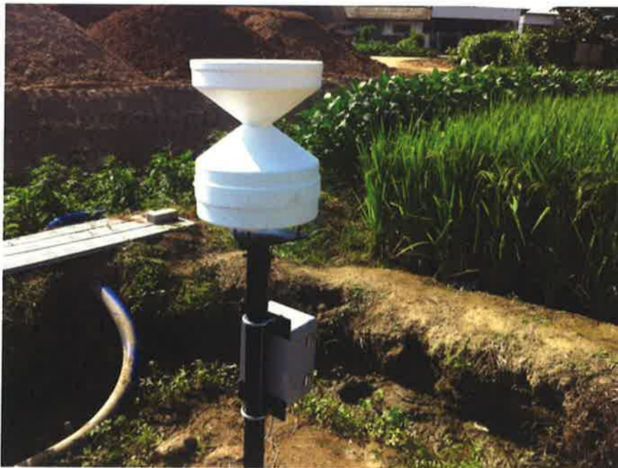
[그림 5.74] 강우량계 Data logger 합체 설치
