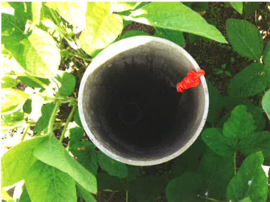
[그림 5.67] 지하수위 관측공 보호 및 수위계 설치 I
