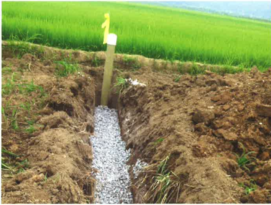
[그림 5.45] 공기변 설치
