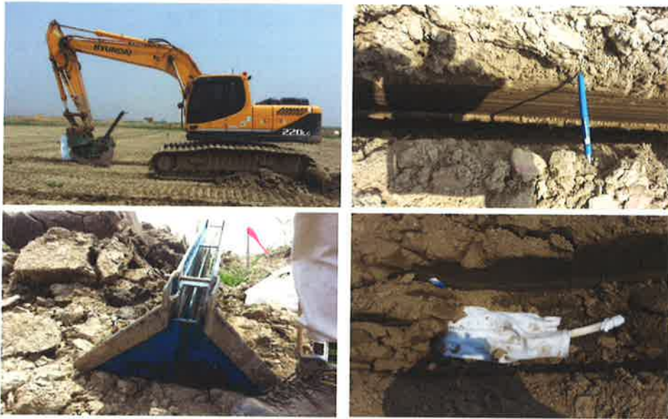
[그림 3.4] 제염암거 시공사례
