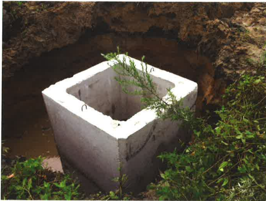
[그림 5.50] 집수정 터파기 및 맨홀 거치
