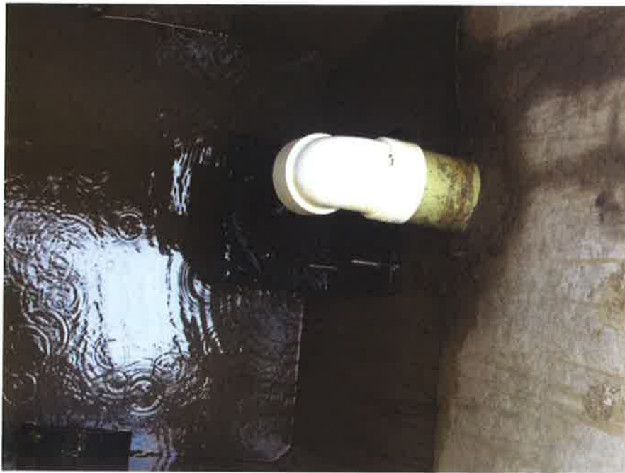
[그림 5.76] 배수량 측정용 강우량계 거치대 설치
