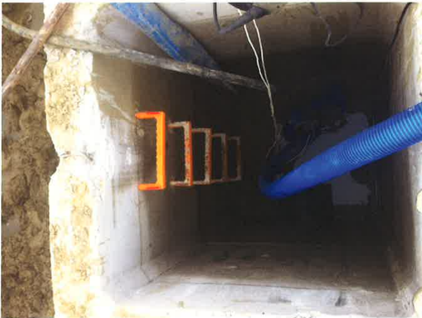
[그림 5.64] 집수정내 배수 펌프 설치
