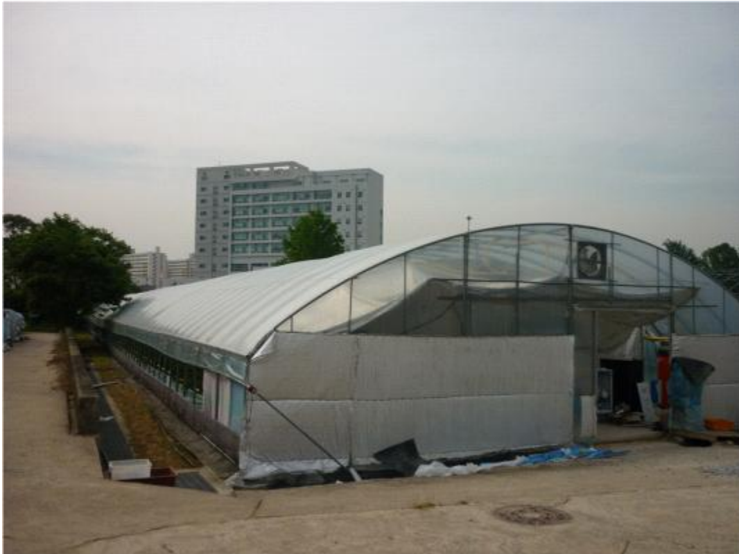
Fig. 1-23. 전남대학교 부속농장 딸기 양액재배용 실험온실(단동 2중 비닐온실)
