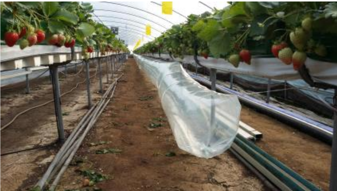
Fig. 3-40. 팬코일 유닛의 송풍팬을 이용한 온풍 순환 및 CO 2 공급
