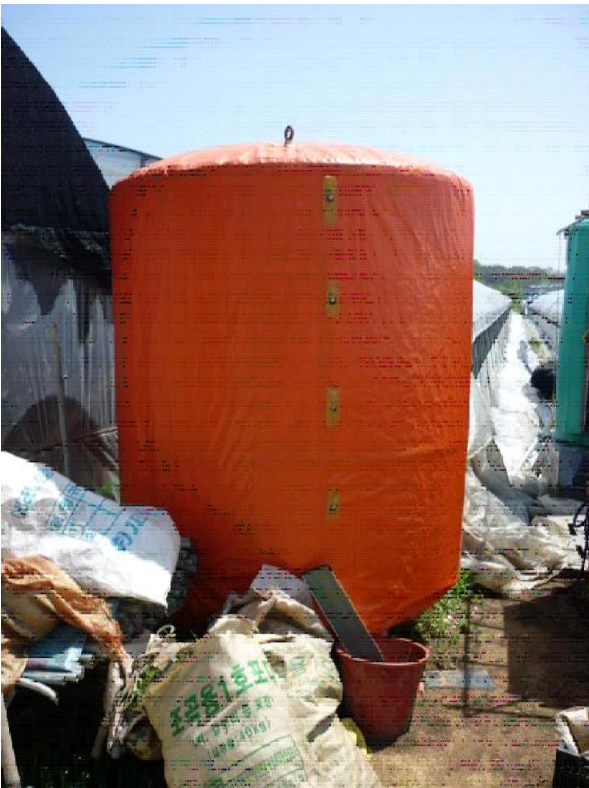
Fig. 2-48. 농가 시설외부에 설치된 3톤규모 축열탱크
