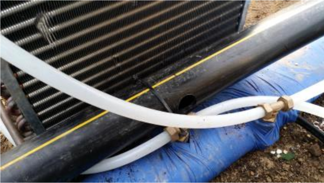
Fig. 3-39. 송풍팬 근처에 설치한 CO 2 공급 관로 배관
