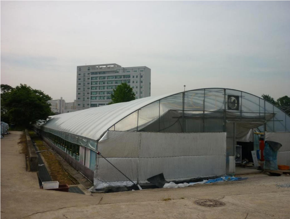
Fig. 2-20. 환경변화 측정 대상 온실.
