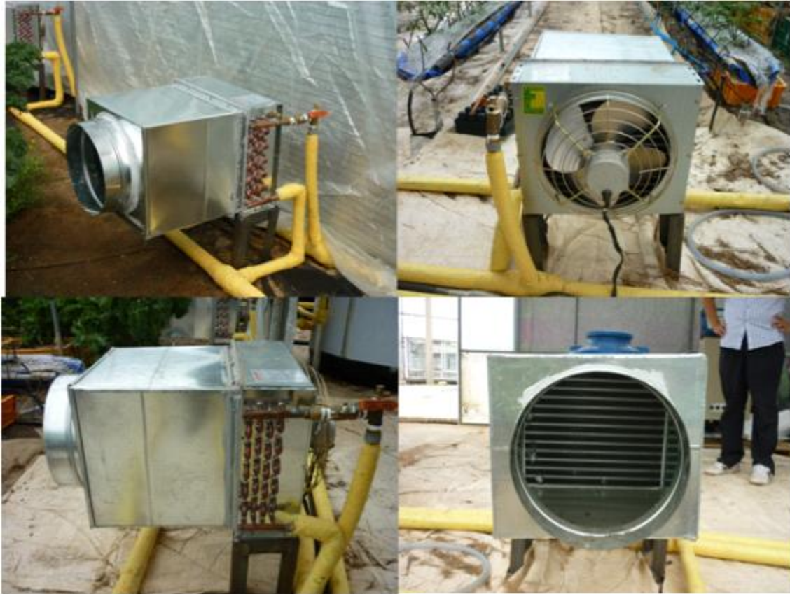
Fig. 1-29. 난방용 팬코일 유닛 배관 및 덕트 연결부 부착
