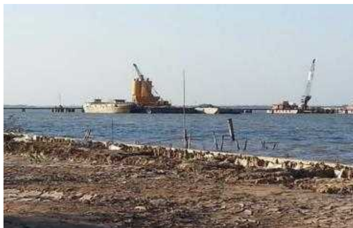
<그림 8-66> 짜빈 교량 건설 사진
