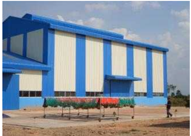
건조·저장시설 공사 완료 후
