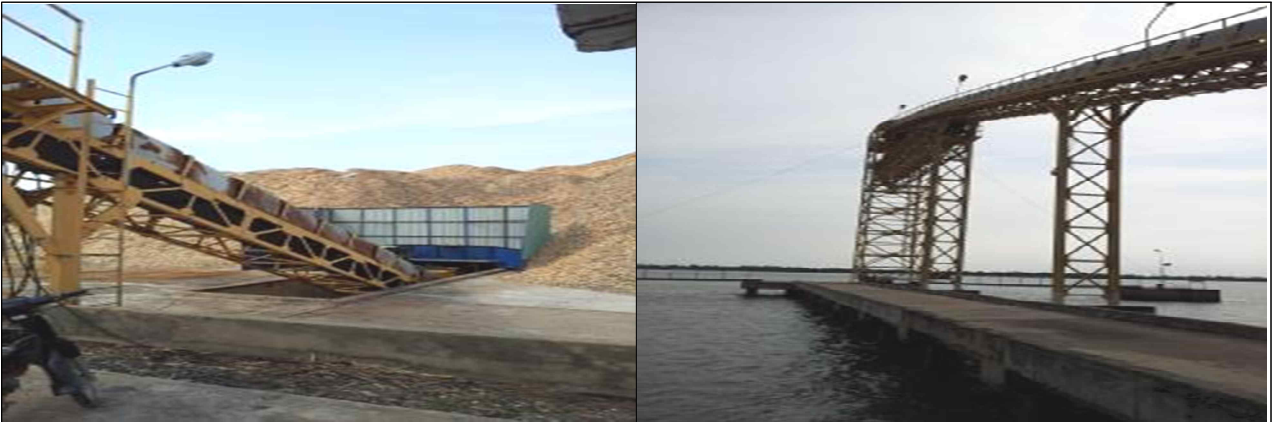
<부도 8-16> 칩 선적용 컨베이어 시설
