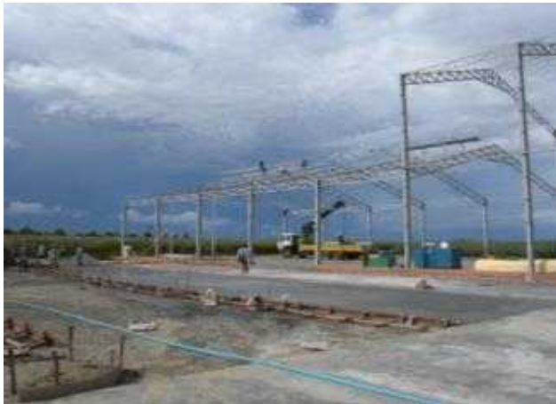
건조·저장시설 공사 모습
