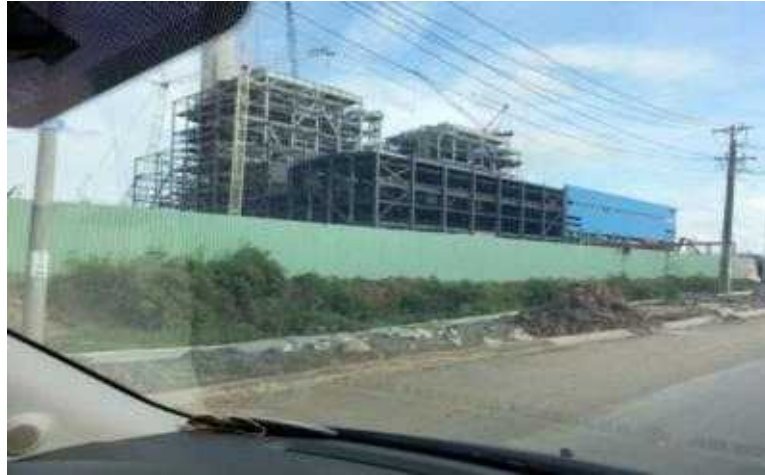
<그림 8-64> 짜빈성 발전소 건설 사진
