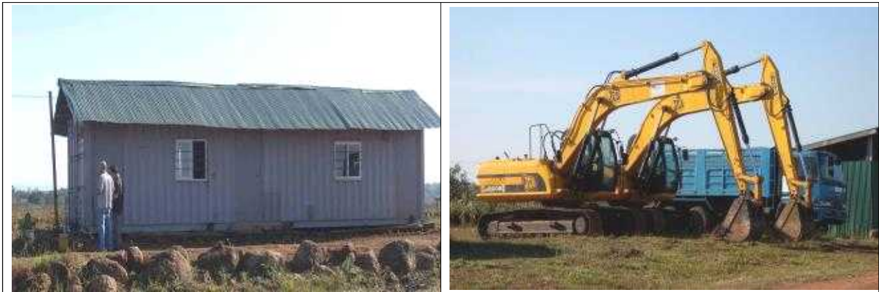
<그림 8-43> 에코프라임의 장비 및 시설 사진
