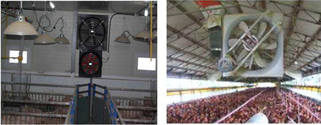
<그림 2-3-2> 일반 축사에 사용되고 있는 환기 시스템.
