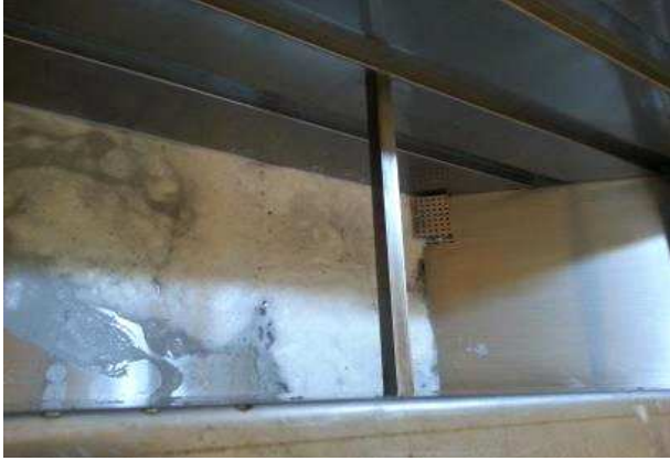
그림 17. 절임조 바닥 : 절임작업 완료 후
