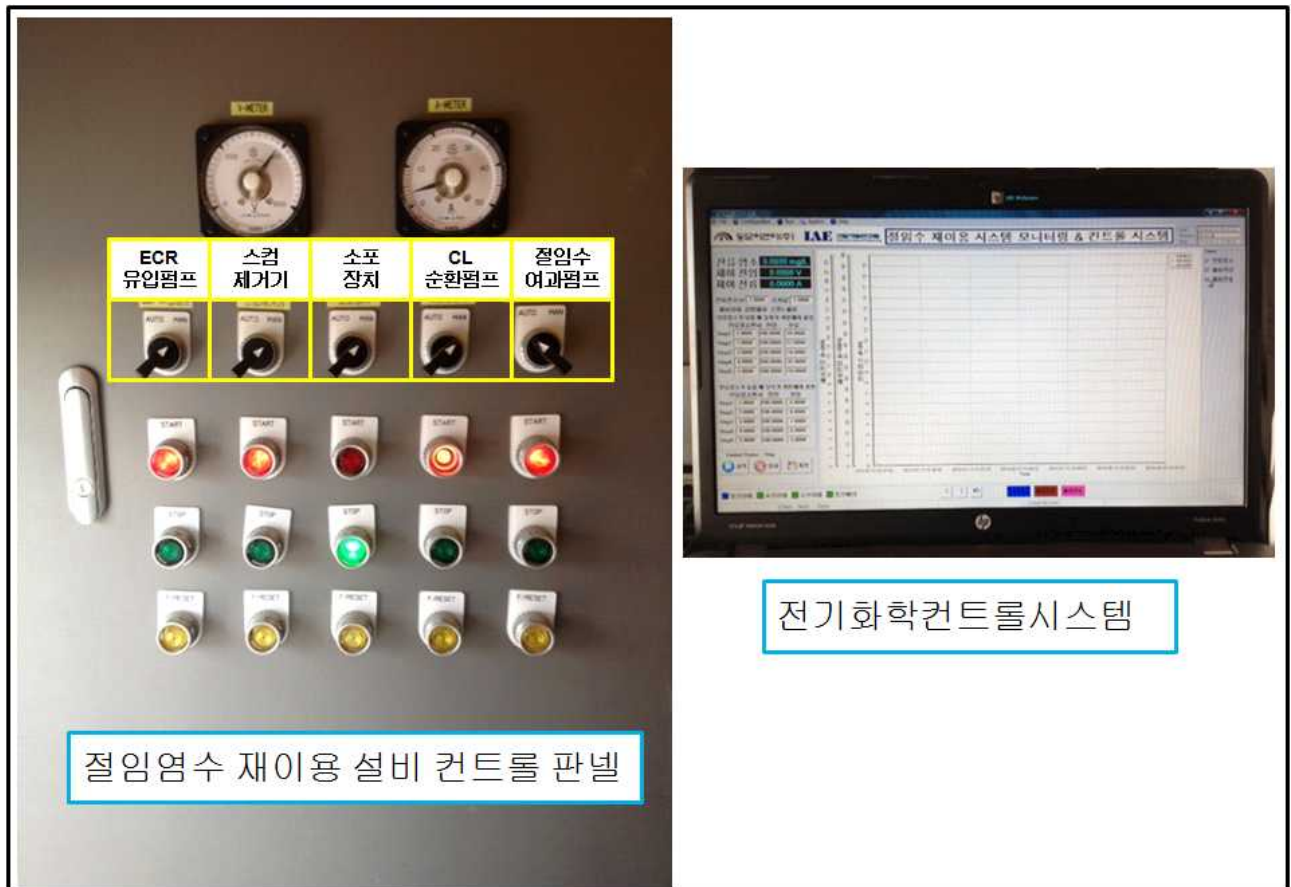
그림 19. 절임염수 재사용 컨트롤 시스템
