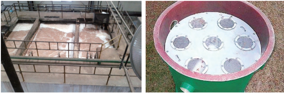
그림 5-7 폭기조(좌)와 공기를 주입하는 파이버글래스 장치(우)
