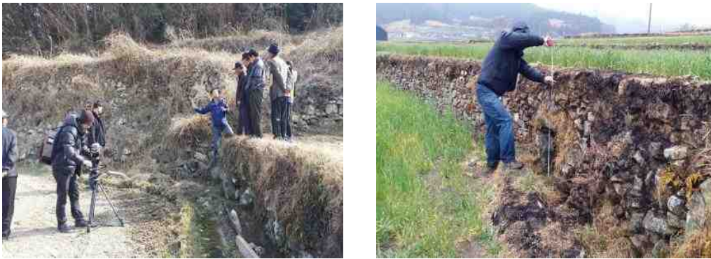
구들장 논 주민동행조사(좌), 현장 실측조사(우)
