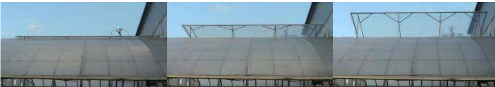
그림 14. 천창 개폐 테스트 전경(전/후)
