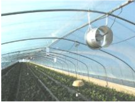
[그림 3-I-254] 온실내 공기순환팬 설치 및 내부 유속
