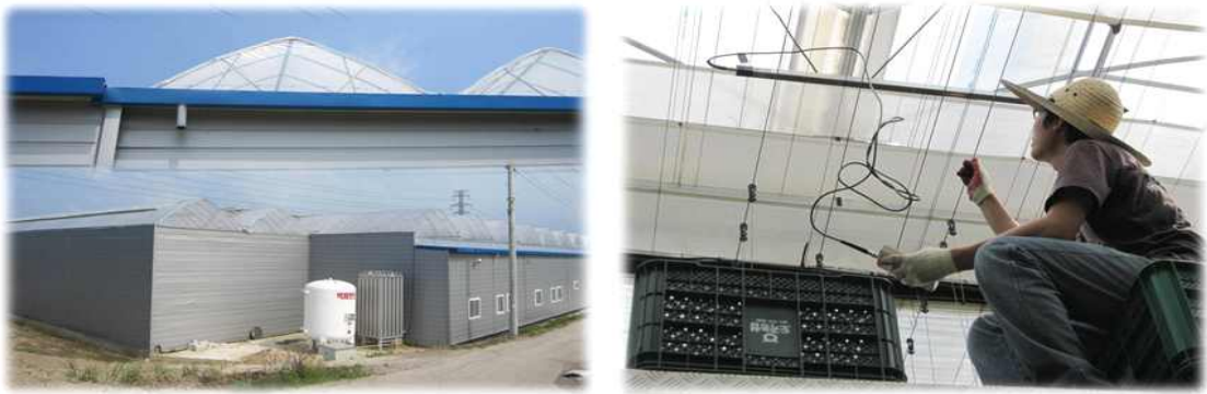
[그림 3-I-271] 화이트(췌크)에 의한 외부차광온실 및 광투과율 측정.
