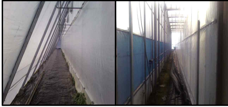
[그림 3-I-158] 방풍벽을 이용한 온실보온.
