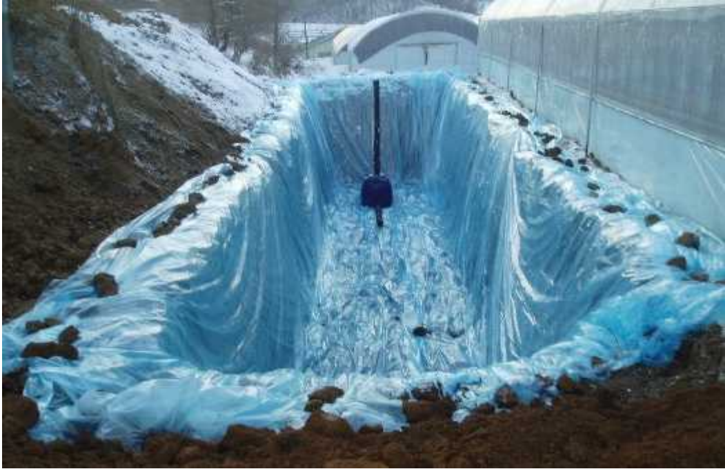
<그림 7> 매몰지 시공 현장
