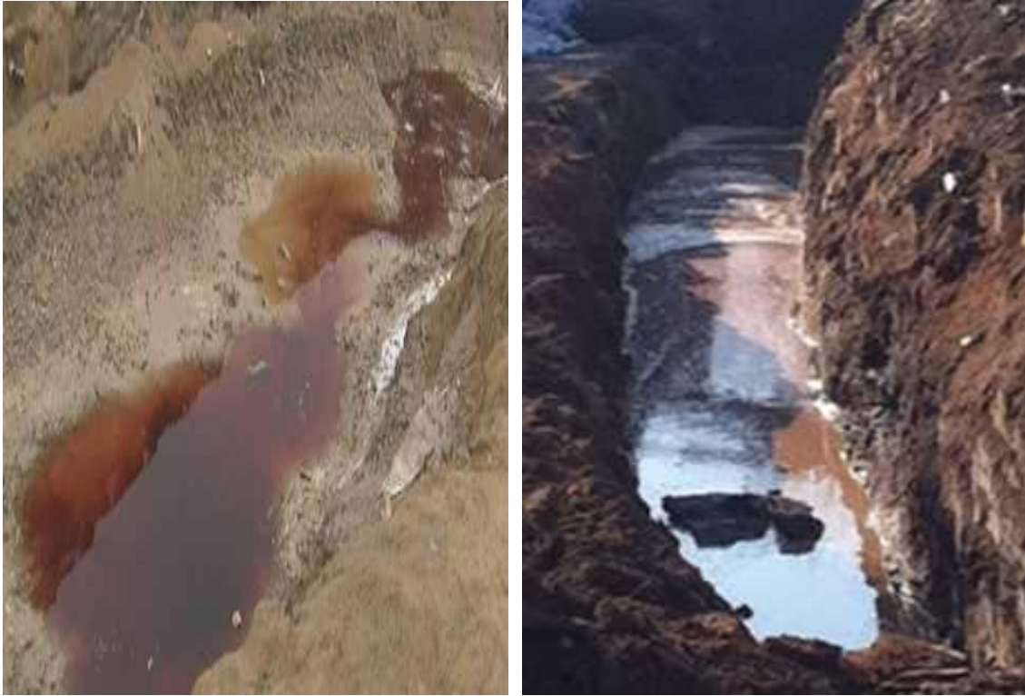
<그림 2> 침출수 유출 현장
