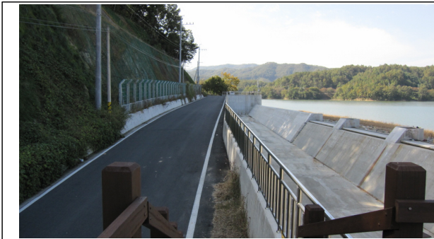
여방수로 도로 연결부
