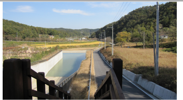
여방수로 도로 연결부
