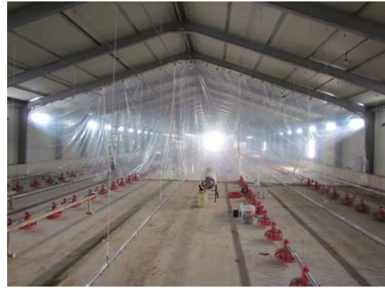
(b) 방수막 설치 완료 전경
