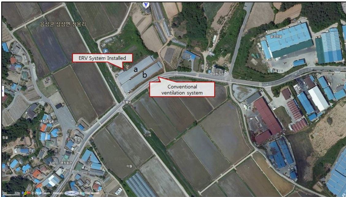
Fig. 3.2.1. 충청북도 음성군 소재 무창계사 2동; a 동: HRV 시스템 설치, b 동: 크로스 환기 팬 및 슬롯형 입기구 등의 일반 환기 시스템 (동절기 기준)
