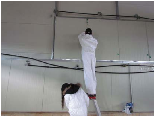
(c) 터널 배기팬 틈새 시공
