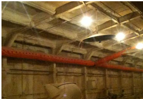
Fig. 3.6.4. HRV DUCT 급기구명
