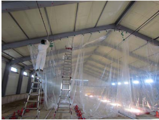
(a) 실험 영역 구분을 위한 방수막 설치
