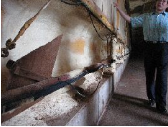
Fig. 3.2.5. 측벽의 우레탄 단열 모습
