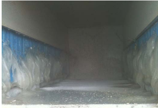
Fig3.5.58 열교환소자 결빙 상태
