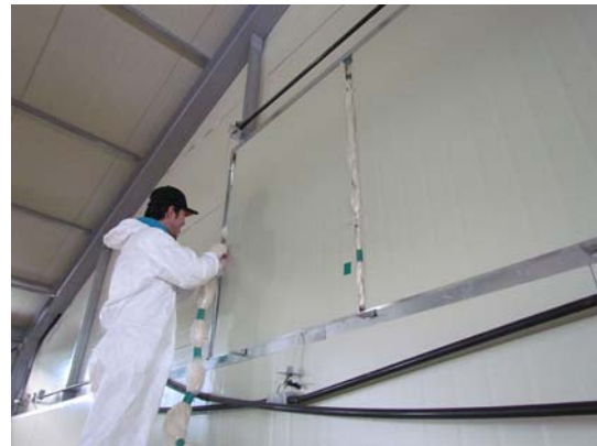
(d) 터널 배기팬 틈새 시공
