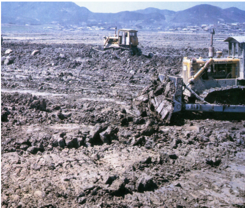
경지정리 공사 광경
