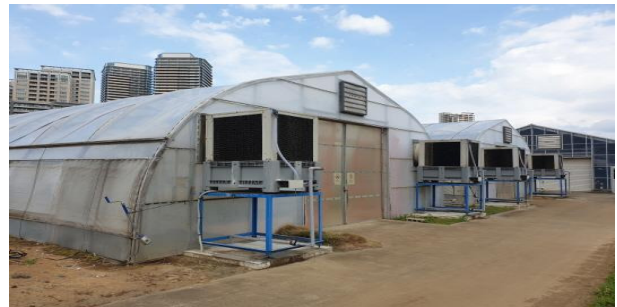
단동형 하우스 팬앤패드 냉각시스템
