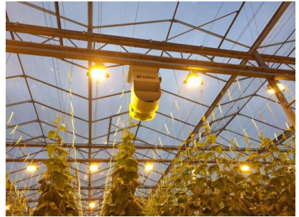
Air Mix 설치
