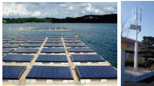
소류지를 이용한 태양광발전(좌) 소형풍력발전설비(우)
