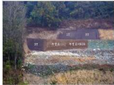
(d) Installation of Nok-native
