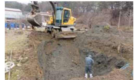
〈그림 18〉 구제역 발생농장 인근 매몰 터파기 작업
