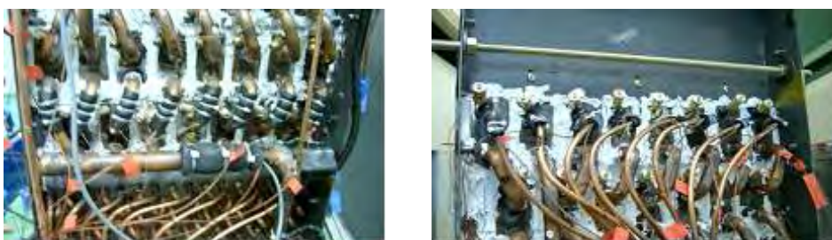
그림 3.31 PCM 축냉모듈로의 냉매 분기관 센서
