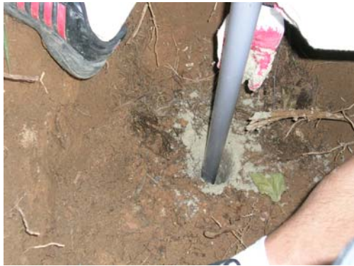
(b) Stand pipe 삽입 및 되메우기
