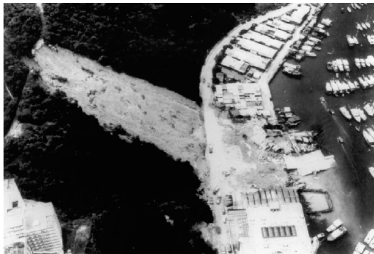
(d) The Shum Wan Road landslide
