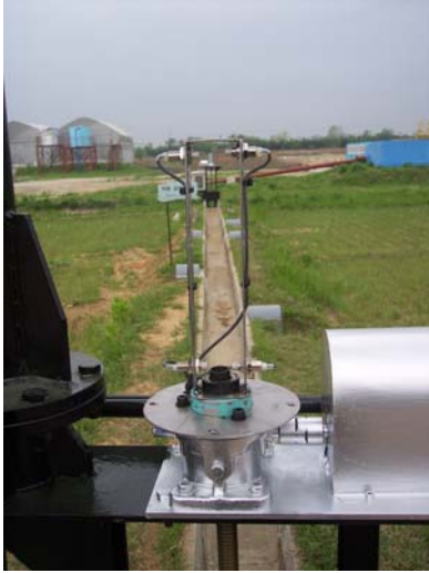
(a) 근접센서 설치 전경
