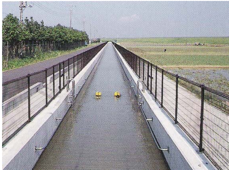
사진 2.2.1.2 하라쿠(邑樂)용수로 전경
