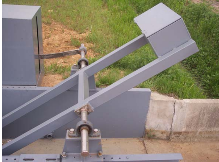
사진 3.1.2.2 무동력 자동수문 밸런스 웨이트(Balance Weight)
