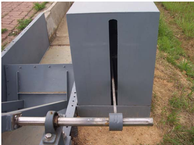
사진 3.1.2.4 무동력 자동수문 플로트 룸(Float Room)
