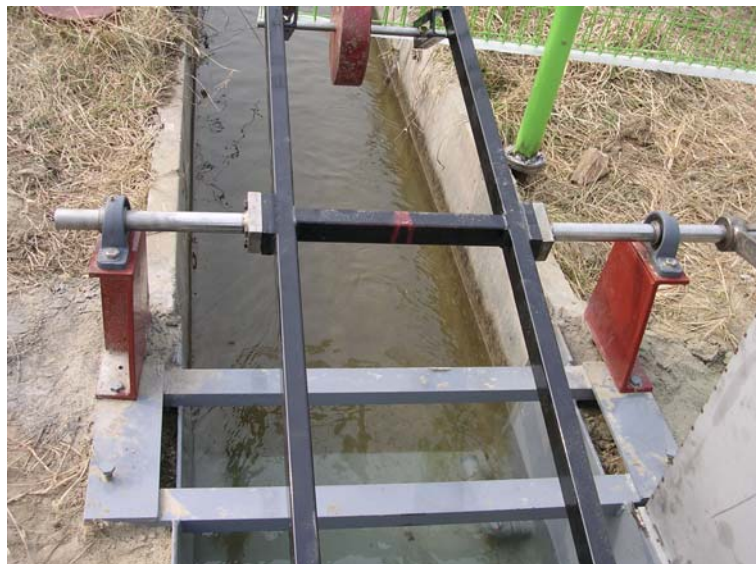
사진 3.1.2.5 무동력 자동수문 힌지(Hinge)
