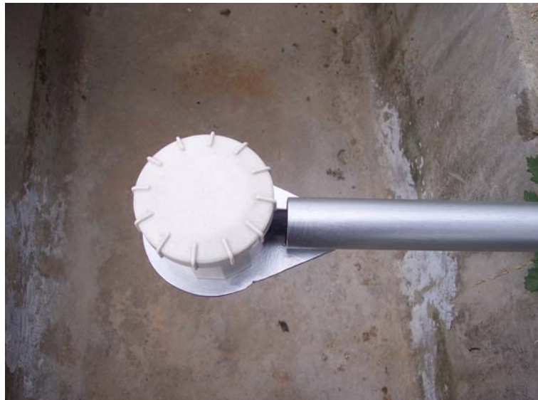
사진 3.1.3.1 설치된 수위감지센서
