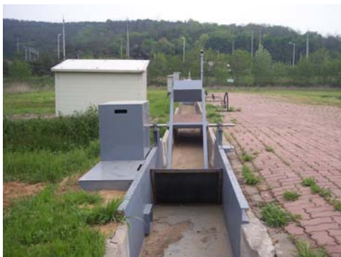
(g) 무동력 자동수문 설치 전경
