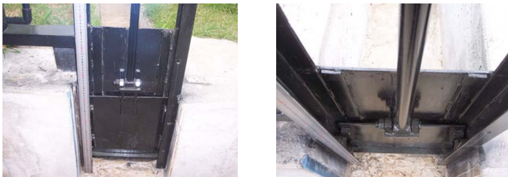
사진 3.1.1.2 태양광 전동 수문 수문비(Skin Plate) 및 지수부
