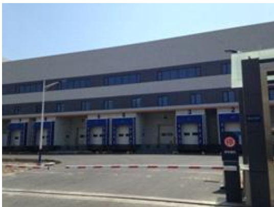
물류 센터 내 입구 앞쪽 전경
