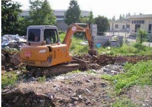
기초 터파기 공사
