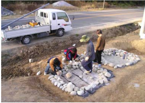
현장 오염용수처리장 조경작업
