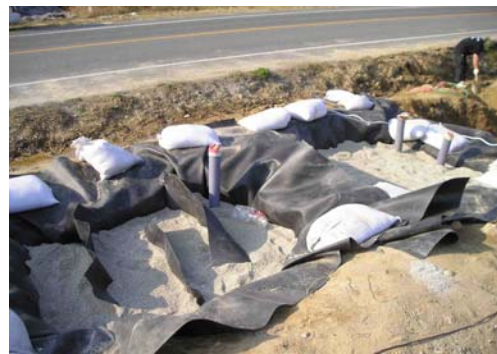
현장 오염용수처리장의 여재조립전경
