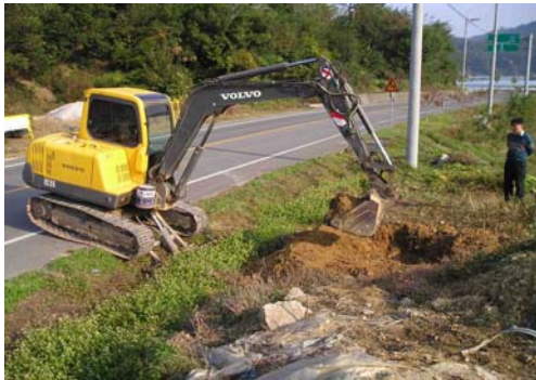
현장 오염용수처리장 기초 터파기
