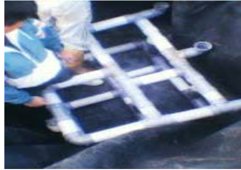
호기성조 내 통기관 작업
