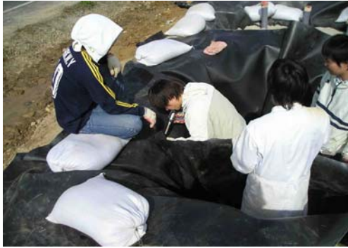
현장 오염용수처리장 차수막 작업
