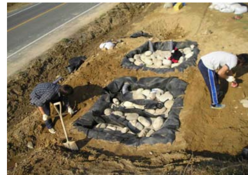
현장 오염용수처리장 주변 평탄작업
