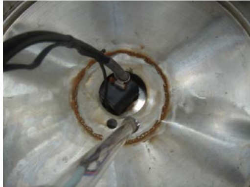
그림 23 집수 및 처리탱크 바닥면에 설치한 잔량부, 수중펌프 및 수위센서 위치
