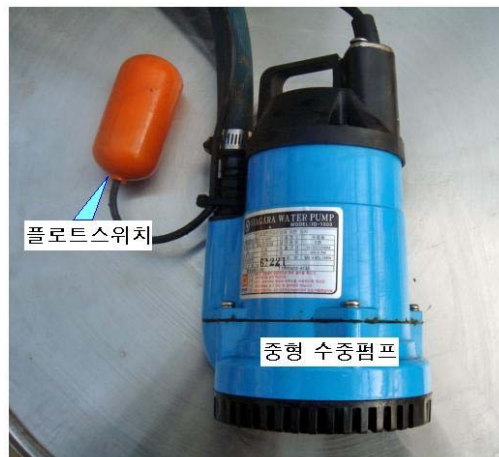
그림 42 급액용 중형 수중펌프 및 플로트 스위치
