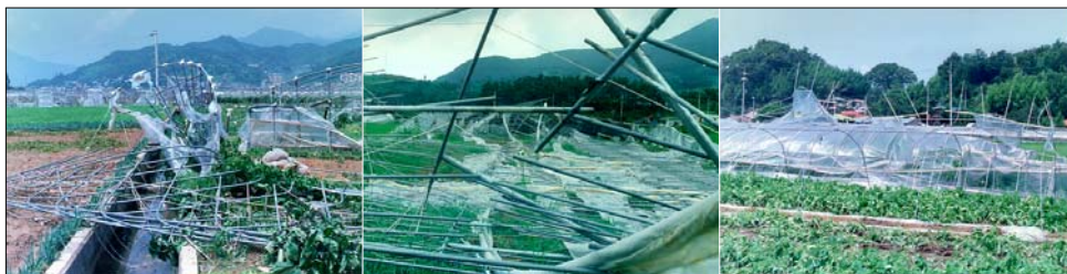
그림 9. 강풍에 의한 온실의 기초인발로 인한 전파 모습
