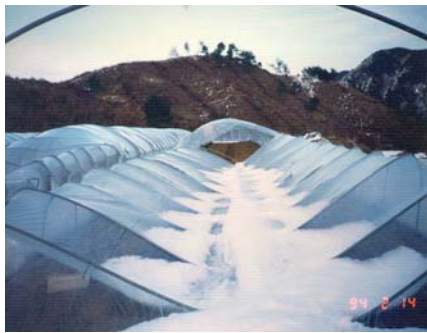
(a) 폭설로 인한 파손 예
