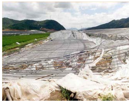
(b) 강풍으로 인한 파손 예
