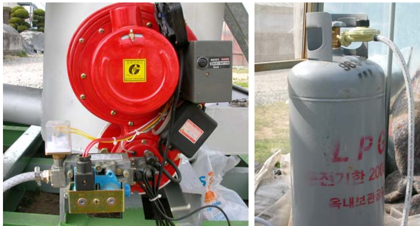
그림 61 자동점화장치에 적용된 가스버너 및 LPG 보관용기
