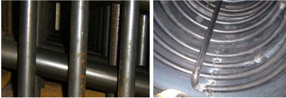
그림 84 축열부의 내부 열교환 파이프의 구조 변경
