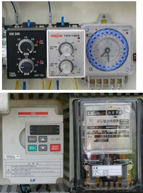
그림 79 시작기의 타이머, 인버터 및 적산전력계
