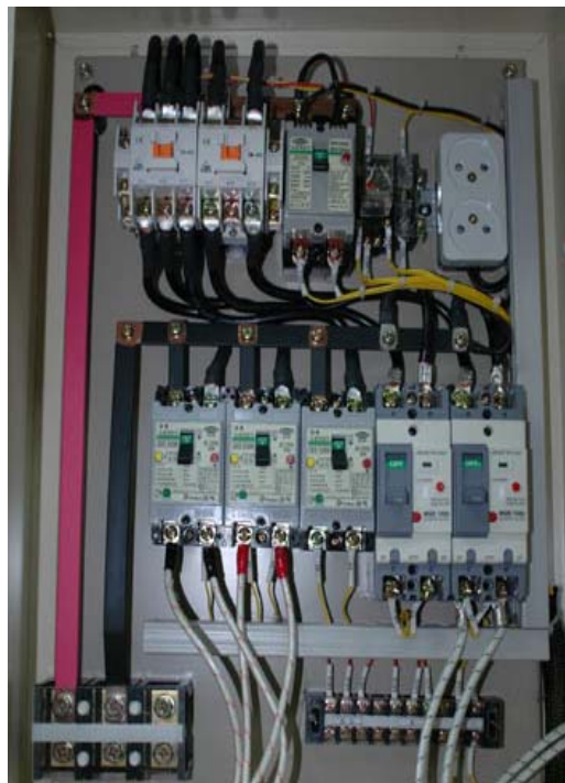
그림 41 잠열축열식 석탄난방기의 보조열원 제어부(B)
