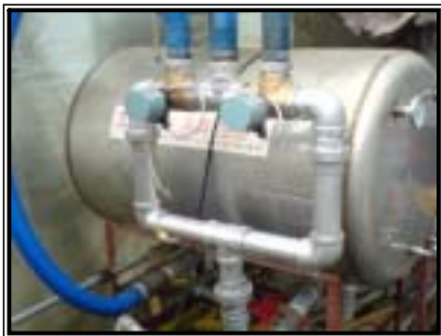
삼방변 전자밸브 시스템이 타사 제품에 연결된 모습
