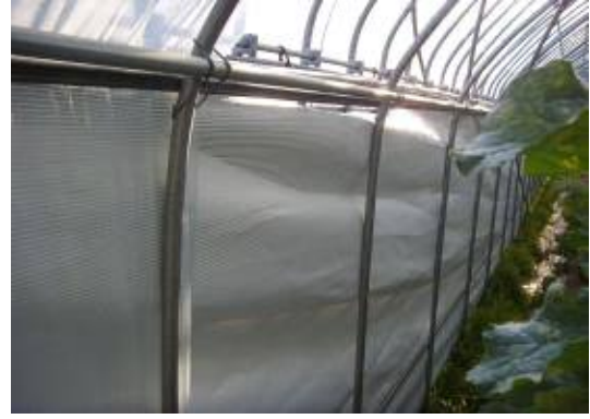
(b) 다겹 보온재의 측면부분 설치
