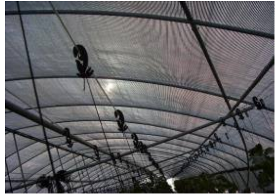
(d) 다겹 보온재의 천장 고정 작업 2
