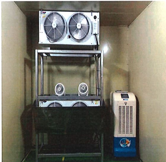
그림 2-38 제습기, 써큘레이터 설치현장
