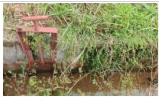
콘크리트 수로의 수문
