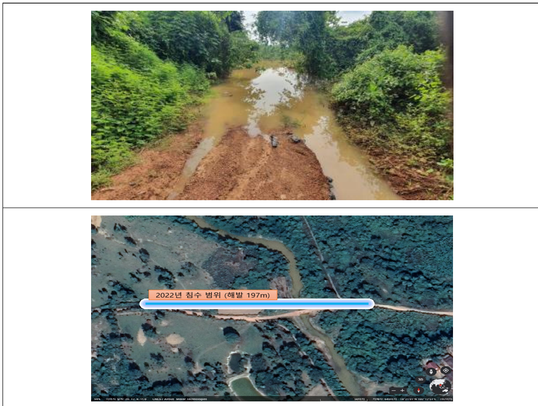
〈그림 4-9〉 사후평가 조사 시 침수된 교량의 시작지점(상)과 구글어스로 추정된 당시 침수 범위(하)
