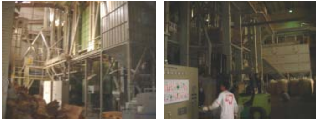
그림 3-3. 가공실내에 조선기 등 반입시설과 건조기가 칸막이 없이 설치된 RPC
