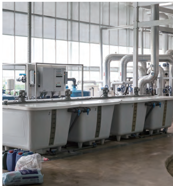
양액공급기 원수와 영양분을 혼합한 양액을 통합시스템의 명령에 따라 작물에 공급한다
