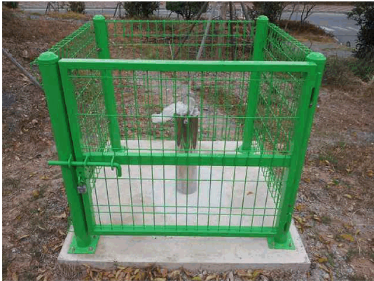
(a) 관측공 굴착, 기초, 보호시설 설치
